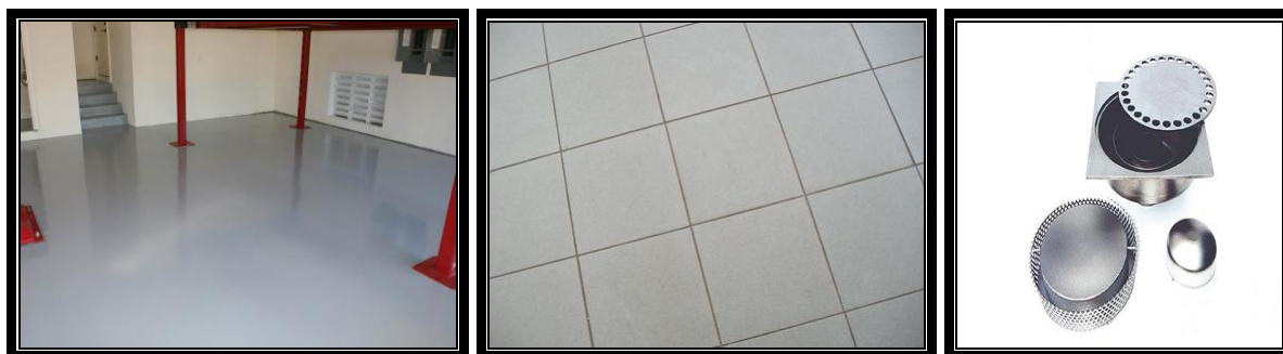
Slika 1. Primjeri prigodnih materijala za oblaganje podova u proizvodnom pogonu i sifon
